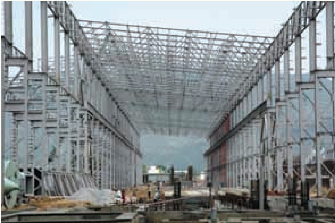
सेलम इस्पात संयंत्र में निर्माणाधीन कोल्ड रोलिंग मिल कॉम्प्लेक्स
