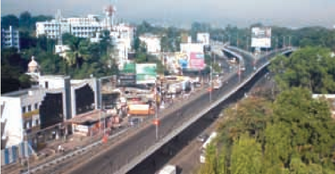
जवाहरलाल नेहरू राष्ट्रीय शहरी नवीकरण मिशन के तहत फ्लाई ओवर का निर्माण
